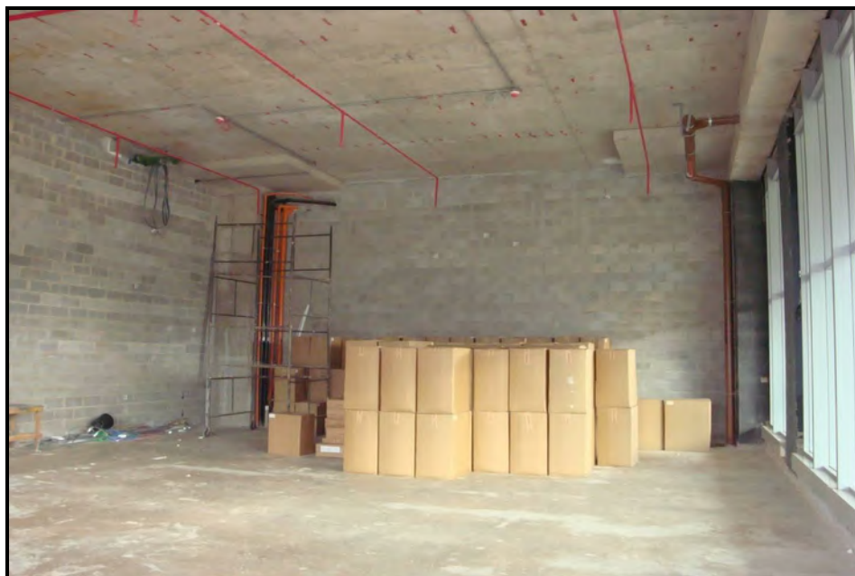
SALA EM REFORMA NO TÉRREO CANTO DA FRENTE COM A LATERAL ESQUERDA
