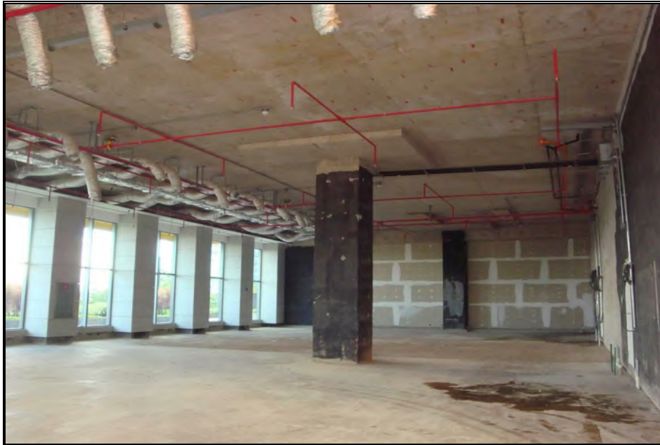
SALA EM REFORMA NO TÉRREO CANTO POSTERIOR, ISTO É, FUNDO COM LATERAL ESQUERDA
