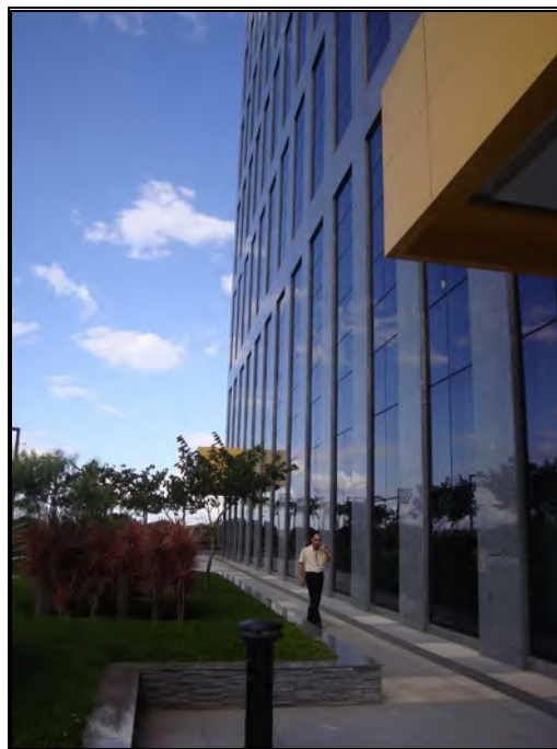
FACHADA LATERAL ESQUERDA (TORRE NORTE) AO NÍVEL DO TÉRREO ONDE HÁ DUAS SALAS EM REFORMA
