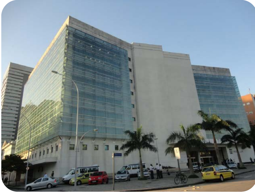
Figura 7 - Fachada do edifício
