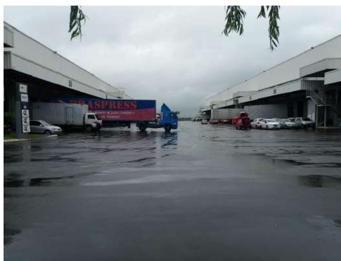
Área de manobra e docas do imóvel
