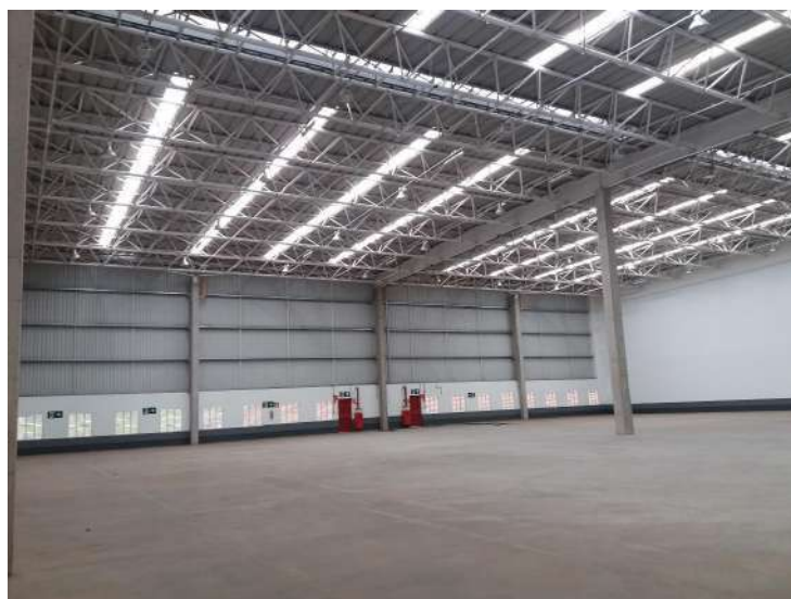
Vista interna do imóvel
