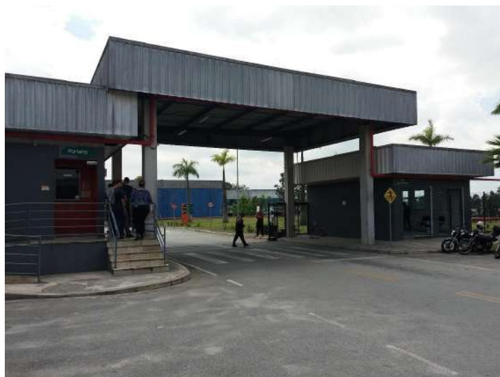
Portaria de acesso
