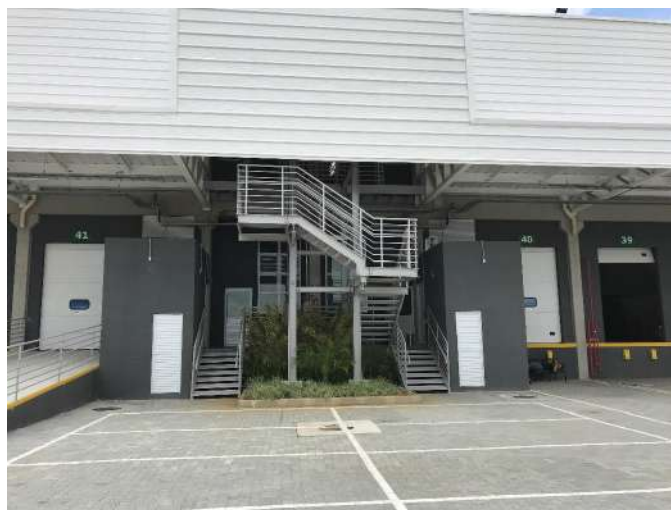
Fachada do galpão
