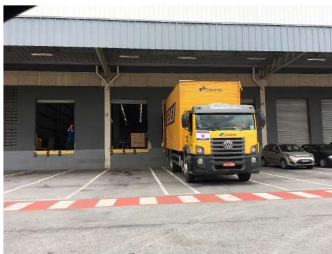
Área de galpão e marquise
