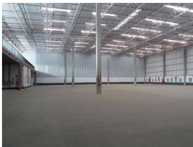
Área interna do galpão
