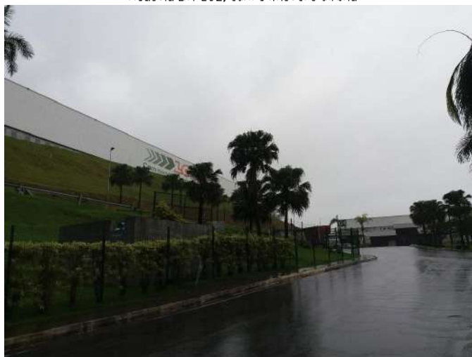
Rodovia BR-262, com o imóvel à esquerda
