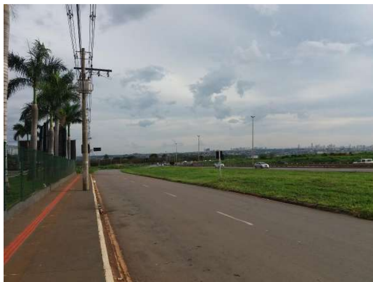
Rodovia BR-153, com o imóvel à esquerda
