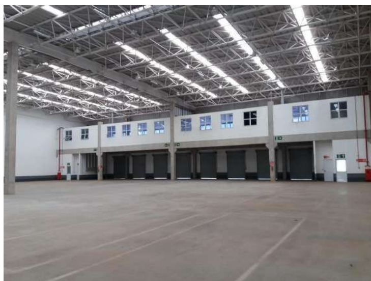
Vista interna do imóvel
