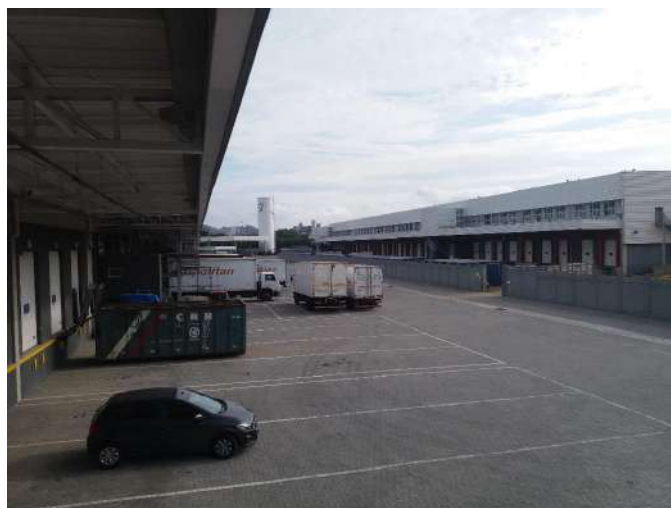
Área de galpão e marquise
